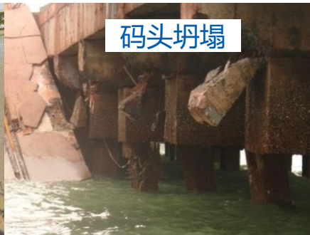
钢筋锈胀开裂
