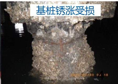
钢筋锈胀开裂
